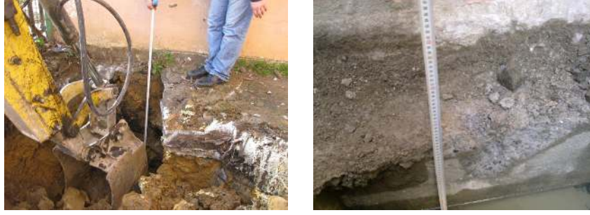
Şekil 4. Binanın dışından ve içinden açılan temel çukurları
